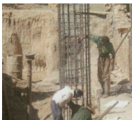
آرماورگذاری شمع تقویتی داخل محل حفاری محل شمع
