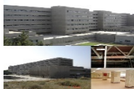
نمائی از پروژه مقاوم سازی بیمارستان بعثت
