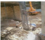
آرماورگذاری شمع ها در محل شمع
