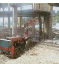
حفاری محل شمع های جدید توسط دستگاه حفار
