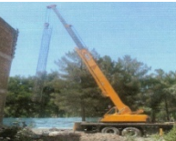
جابجای آرماور شمع توسط جرثقیل
